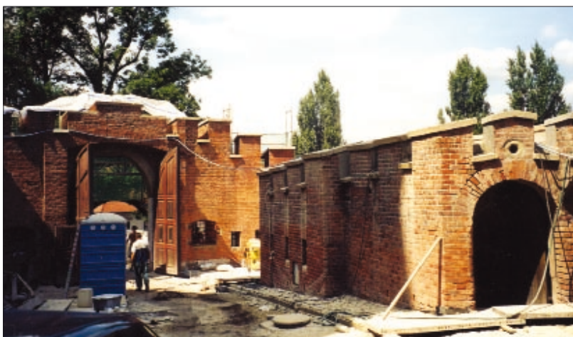
Prace osuszeniowe podczas renowacji bastei austriackiej na Wawelu
