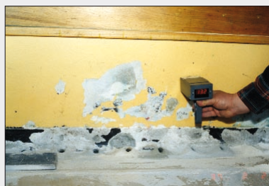
Pomiar poziomu zawilgocenia muru w trakcie prac osuszających
